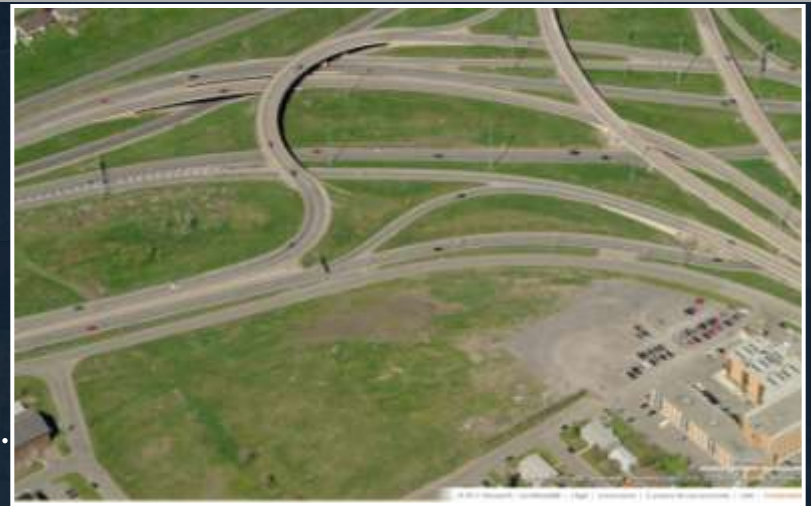
Nord de l'avenue des Hôtels
