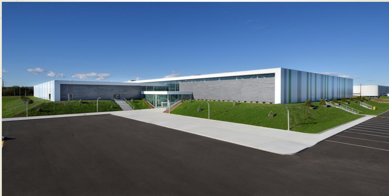
Complexe multifonctionnel St-Augustin de Desmaures
